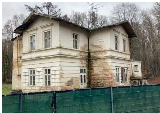
Seedeichstraße 17 „Villa Adler“
