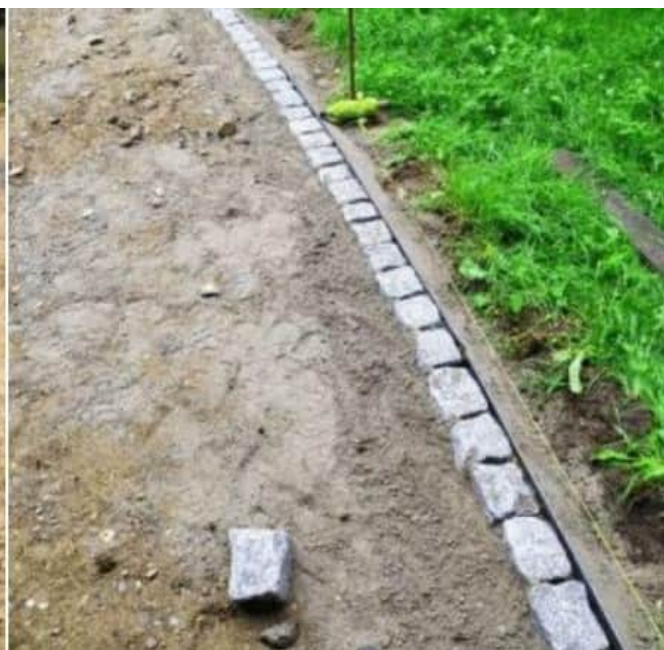
in Bau befindliche Wegekannte
