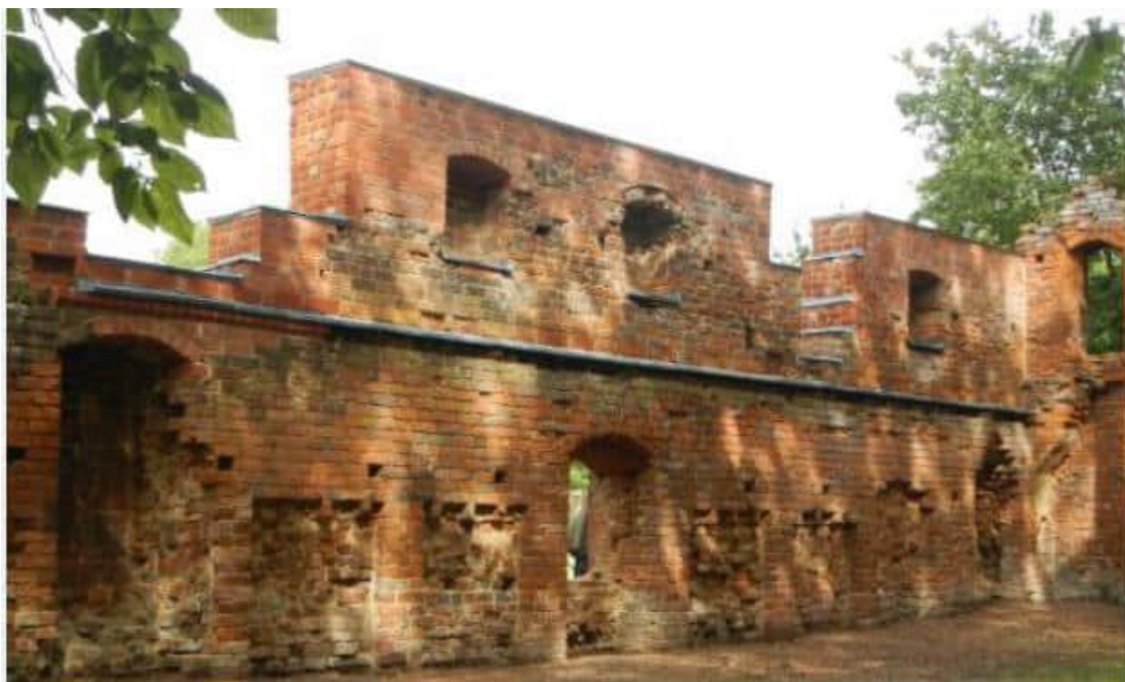
Der fertige 1. Abschnitt der Nordwand von Süden © P. Petersen
