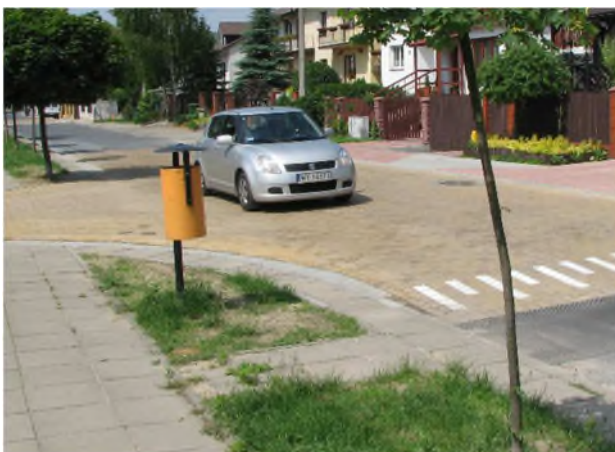
Abbildung 7-5: Aufpflasterung am Knotenpunkt
