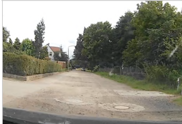
Abbildung 5-8: Schwachstelle FV 3 Gehwege mit baulichen Mängeln
